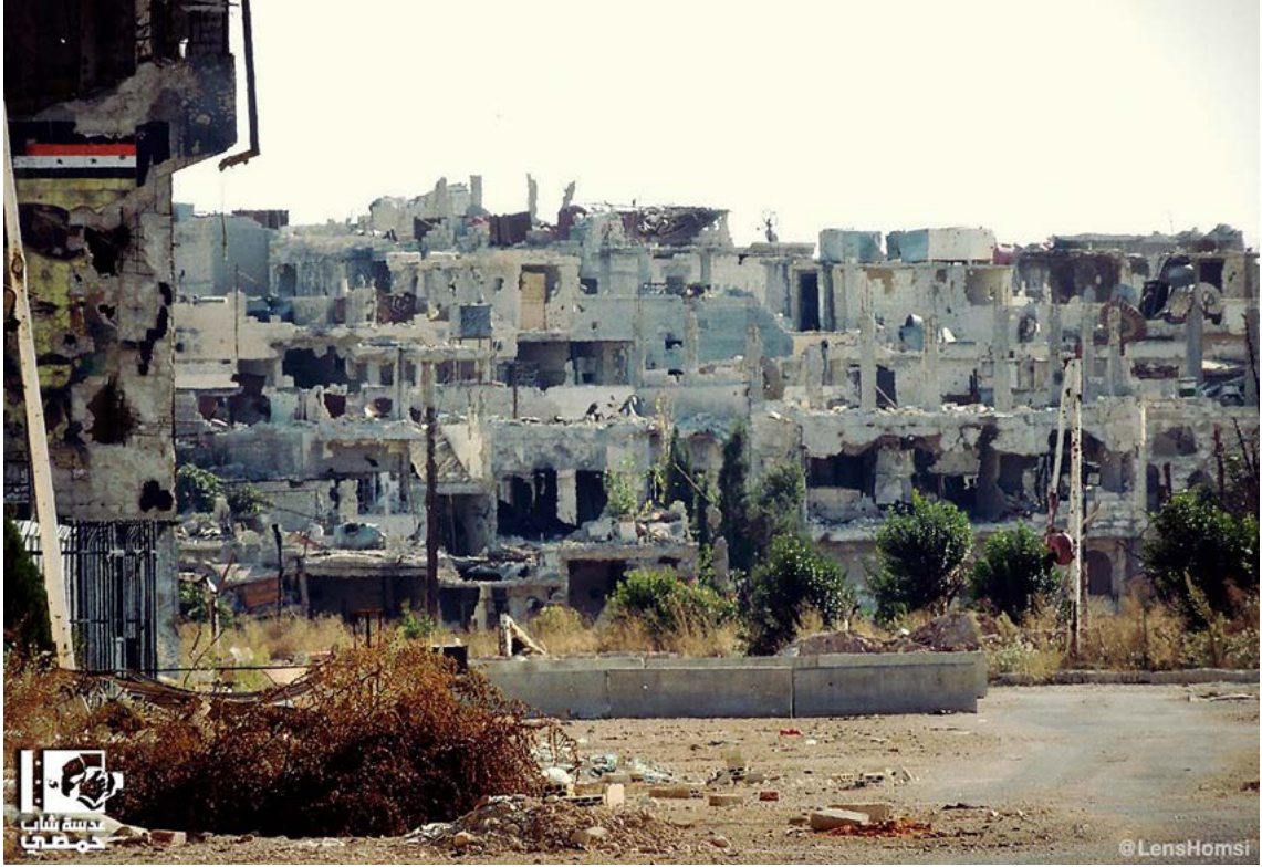
أنقاض المباني في بابا عمرو بعد الحصار
